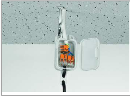
Anschluss von Pendelleuchten in abgehängten Decken
